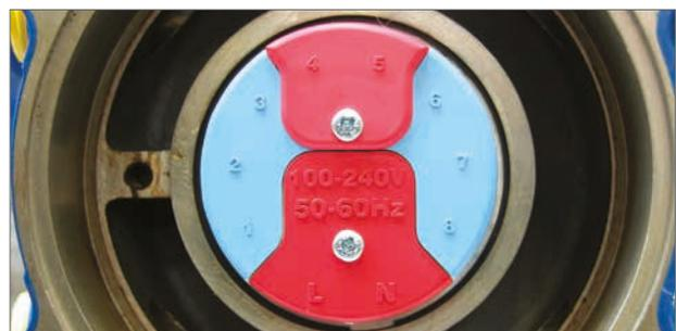
Fig 7.16 Bloque de terminales IS
